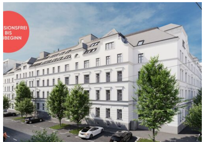
Rosegggasse | Fassade Tag
