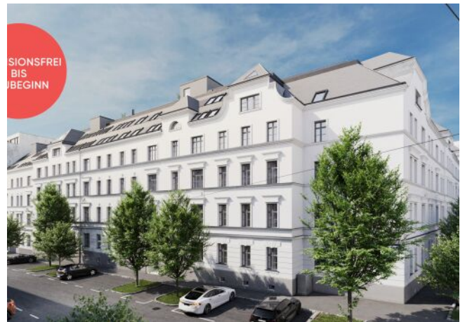
Rosegggasse | Fassade Tag
