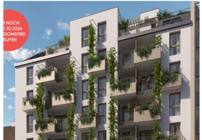
Ottakringer Straße 26 | Fassade
