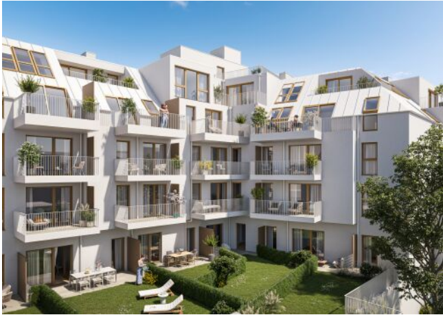
Schumannngasse | Fassade Süd
