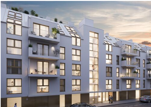
Schumanngasse | Fassade Straße
