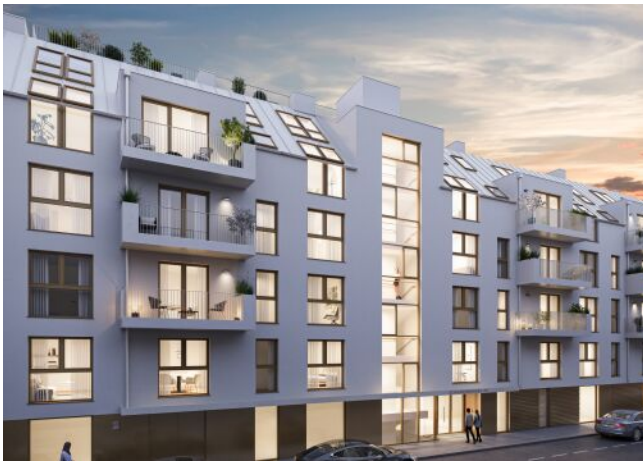
Schumanngasse | Fassade Straße
