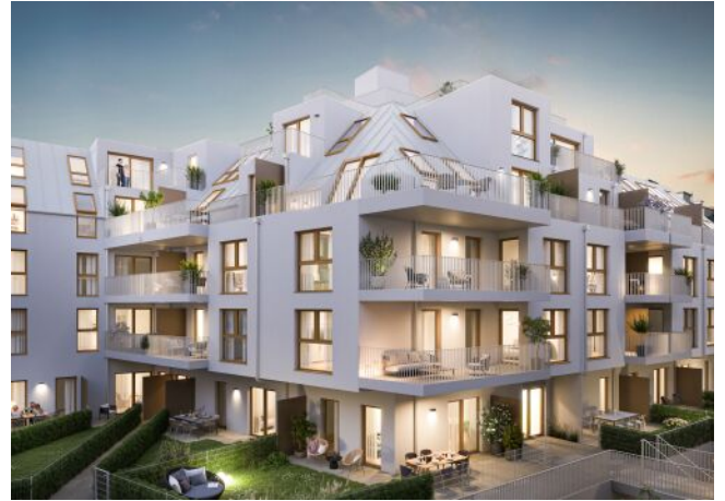
Schumannngasse | Fassade Nord Abend
