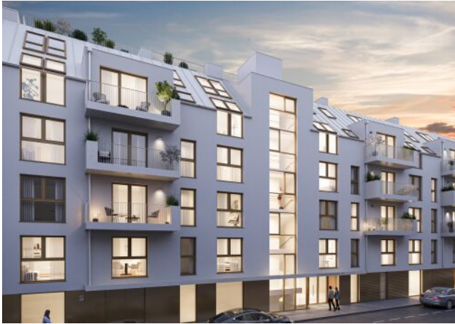
Schumanngasse | Fassade Straße
