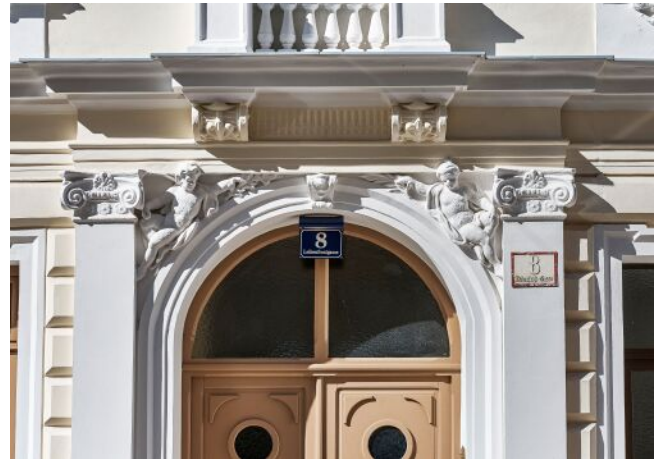
Leibnizgasse 8 | Fassade Detail
