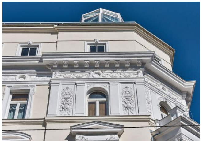
Leibenfrostgasse 8 | Fassade Detail
