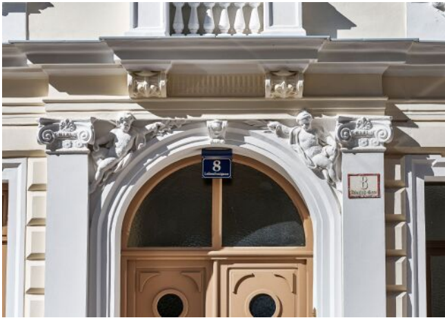
Leibenfrostgasse 8 | Fassade Detail
