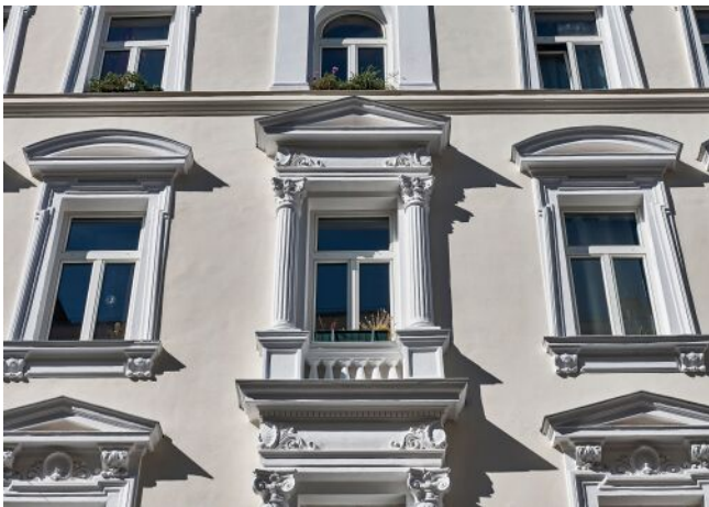
Leibenfrostgasse 8 | Fassade Detail
