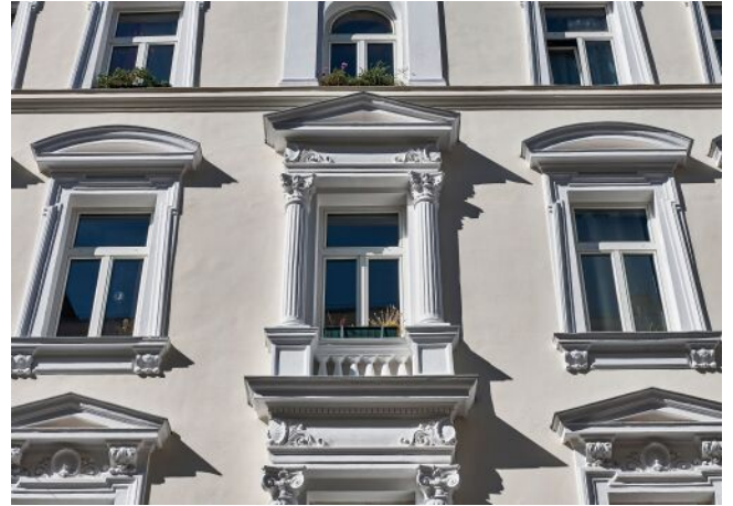
Leibenfrostgasse 8 | Fassade Detail
