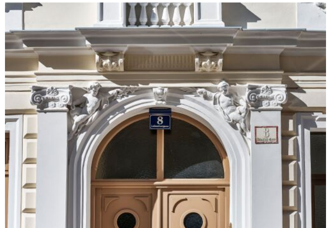
Leibenfrostgasse 8 | Fassade Detail
