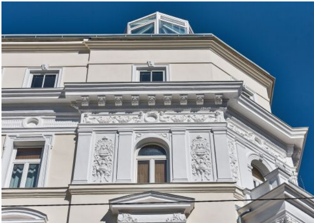
Leibenfrostgasse 8 | Fassade Detail
