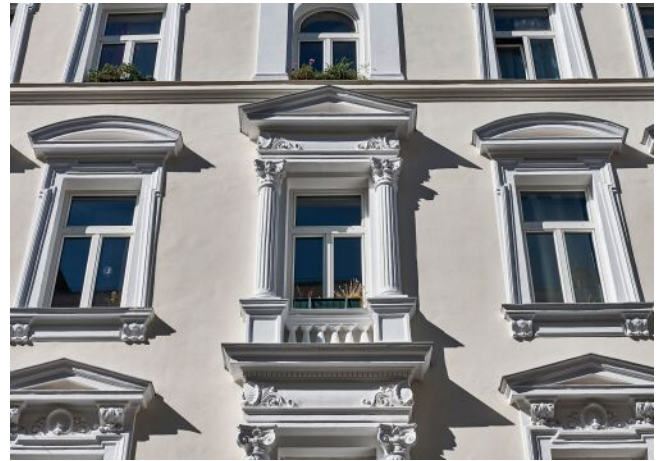
Leibenfrostgasse 8 | Fassade Detail
