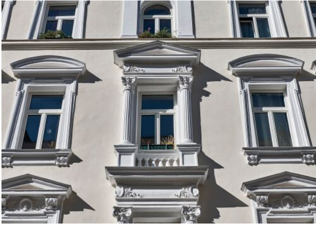
Leibenfrostgasse 8 | Fassade Detail
