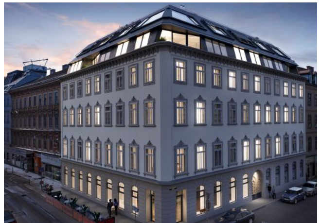
Essenz No. 1 | Fassade Abend
