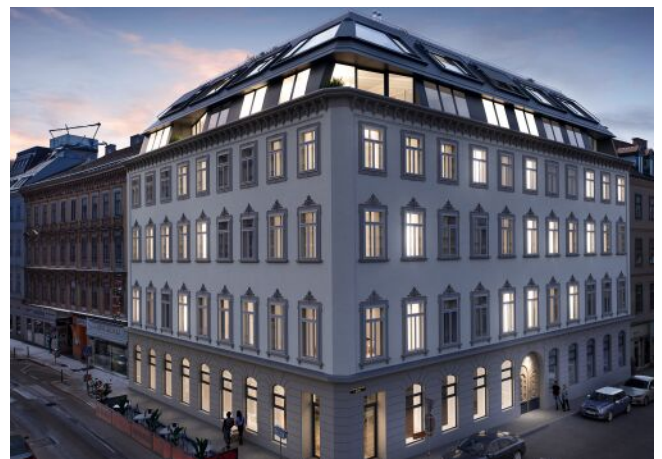
Essenz No. 1 | Fassade Abend
