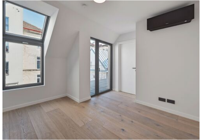
hofseitiges Schlafzimmer mit Terrassenzugang
