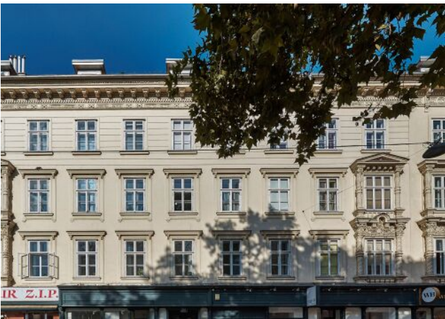
Schönbrunner Straße 20-24 | Fassade
