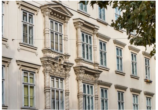
Schönbrunner Straße 20-24 | Fassade
