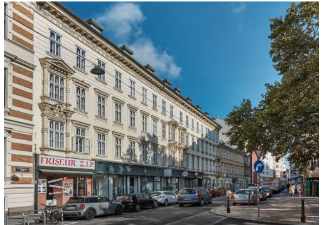
Schönbrunner Straße 20-24 | Fassade
