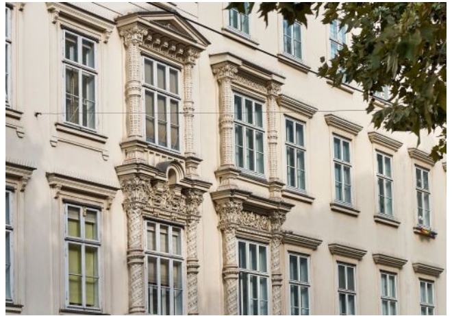
Schönbrunner Straße 20-24 | Fassade
