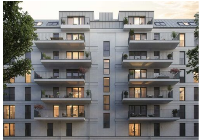
Wiedner Hauptstrasse 140 | Fassade Straße
