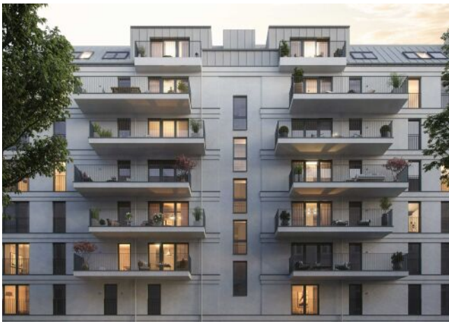
Wiedner Hauptstrasse 140 | Fassade Straße
