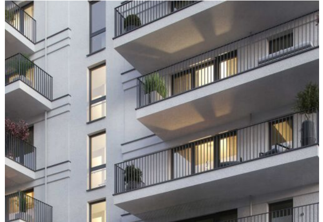
Wiedner Hauptstrasse 140 | Fassade Straße
