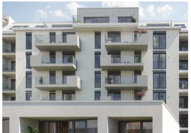
Wiedner Hauptstrasse 140 | Fassade Hof
