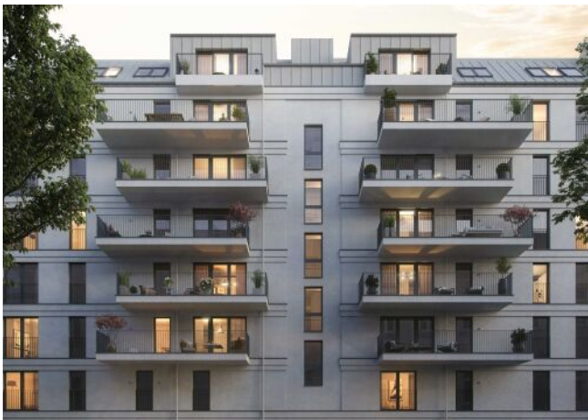
Wiedner Hauptstrasse 140 | Fassade Straße
