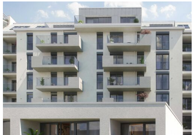
Wiedner Hauptstrasse 140 | Fassade Hof
