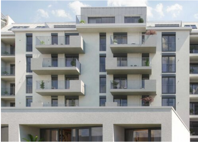
Wiedner Hauptstrasse 140 | Fassade Hof
