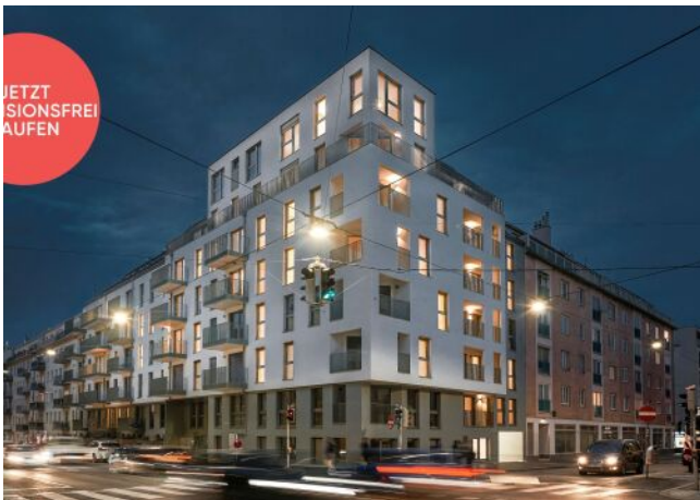
Arndtstraße 50 | Fassade Nacht
