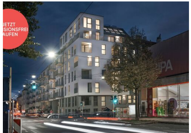
Arndtstraße 50 | Fassade Nacht
