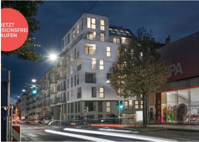
Arndtstraße 50 | Fassade Nacht
