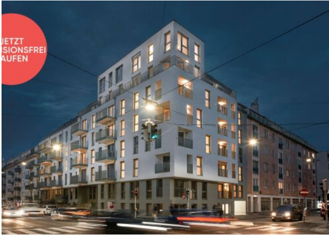
Arndtstraße 50 | Fassade Nacht
