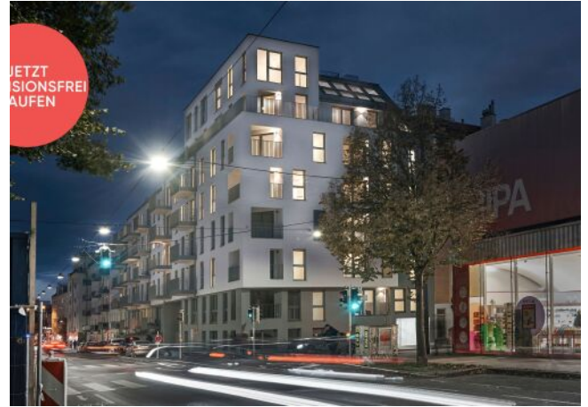
Arndtstraße 50 | Fassade Nacht
