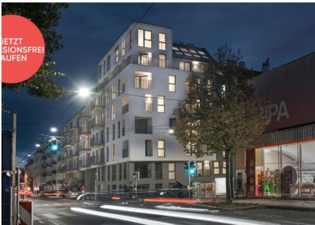
Arndtstraße 50 | Fassade Nacht
