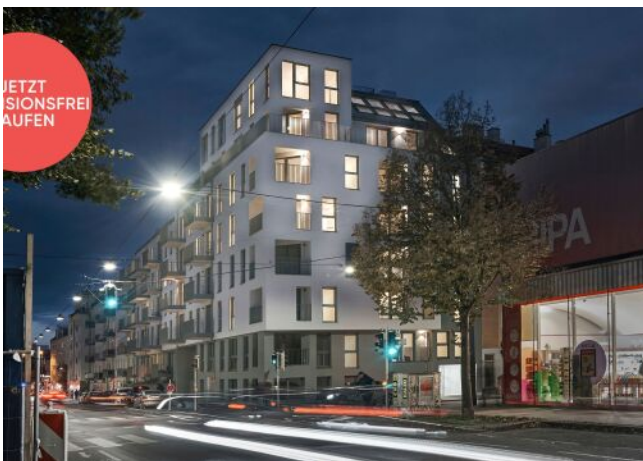
Arndtstraße 50 | Fassade Nacht
