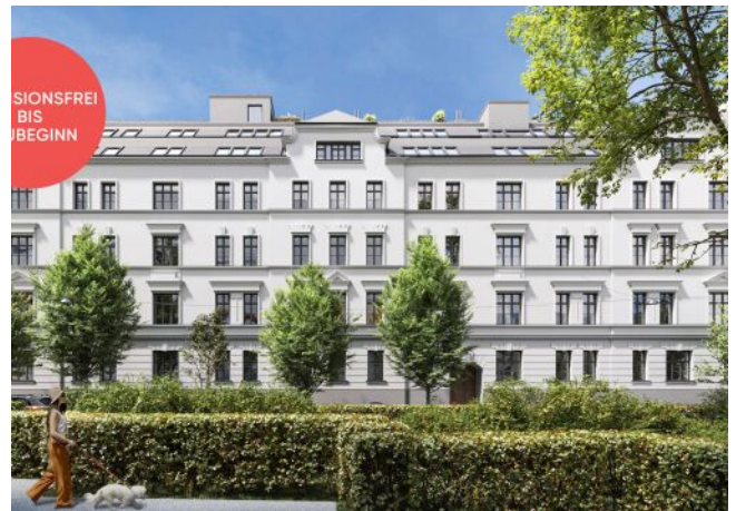
Rosegggasse | Fassade Frontal
