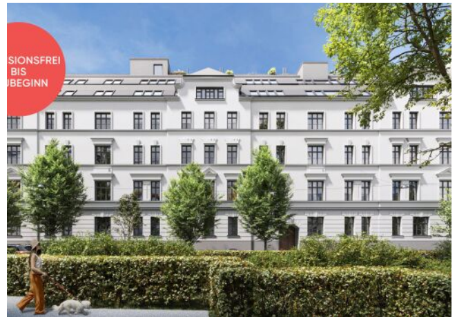
Rosegggasse | Fassade Frontal
