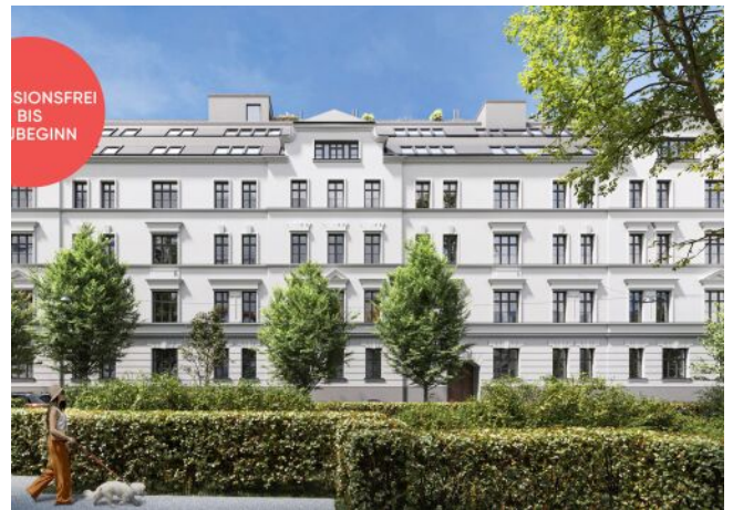
Rosegggasse | Fassade Frontal
