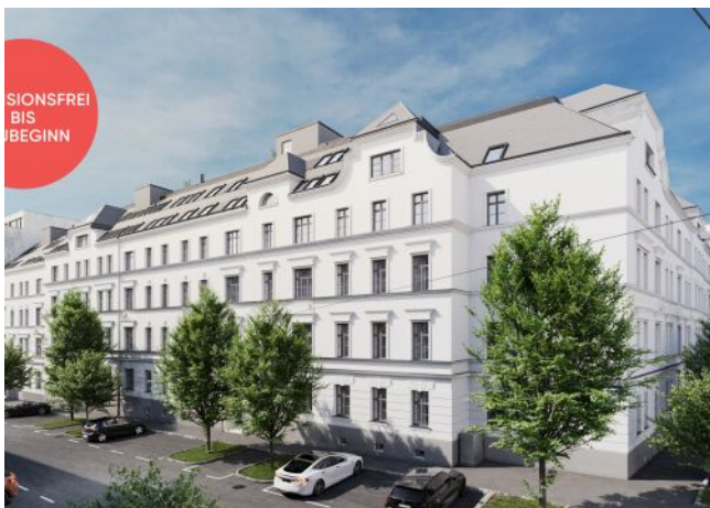
Rosegggasse | Fassade Tag
