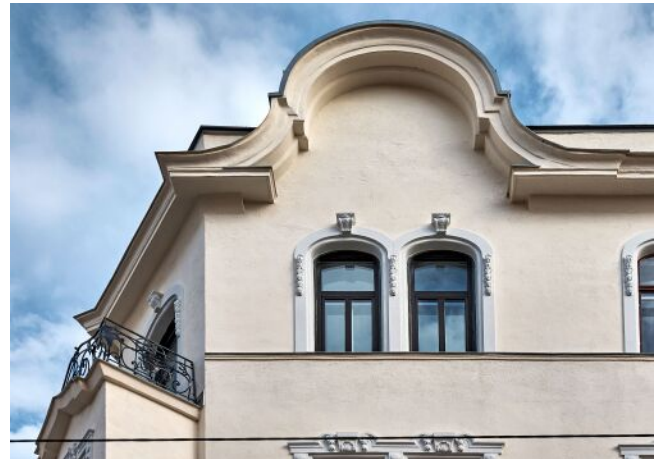
Bergsteiggasse 26A | Fassade
