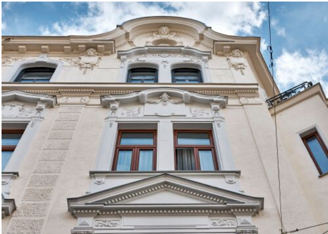
Bergsteiggasse 26A | Fassade
