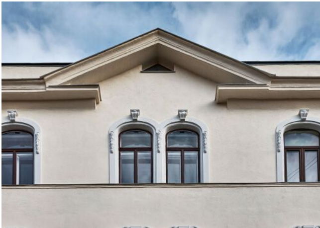
Bergsteiggasse 26A | Fassade
