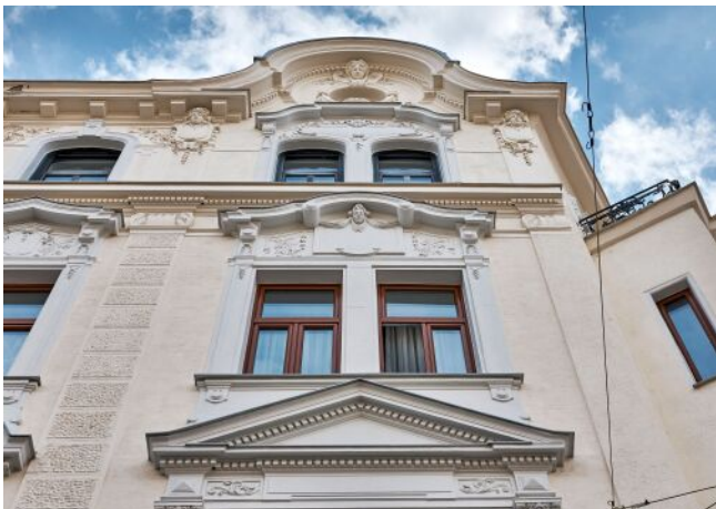
Bergsteiggasse 26A | Fassade
