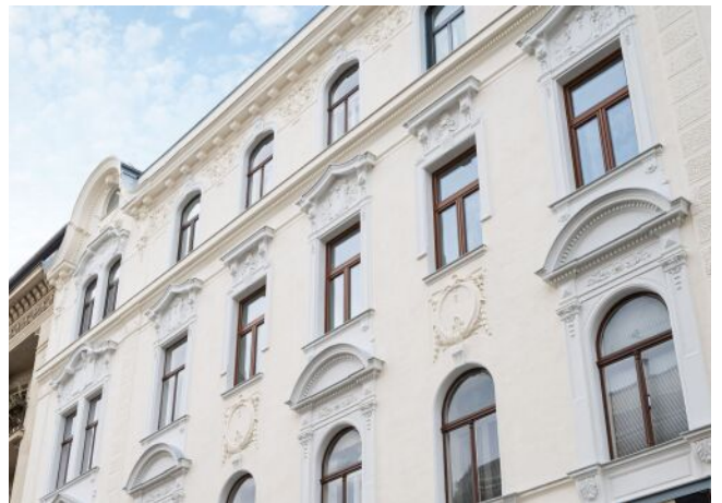
Bergsteiggasse 26A | Fassade
