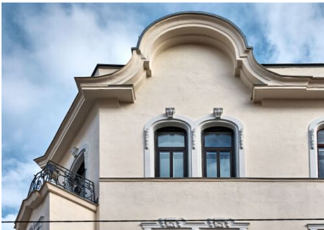
Bergsteiggasse 26A | Fassade
