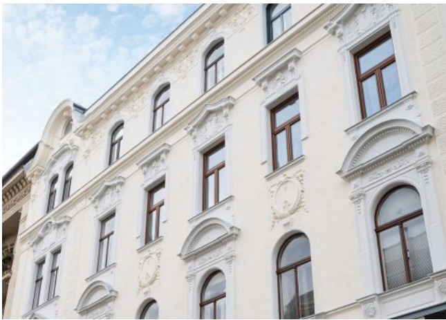
Bergsteiggasse 26A | Fassade
