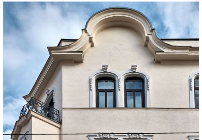
Bergsteiggasse 26A | Fassade
