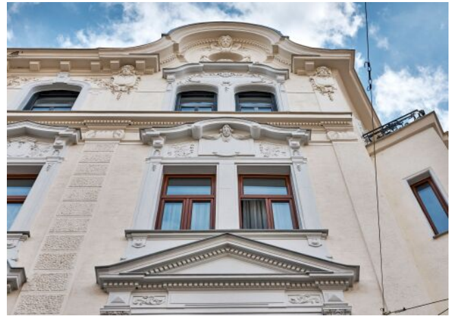
Bergsteiggasse 26A | Fassade
