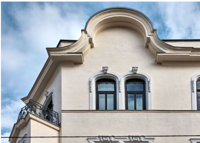
Bergsteiggasse 26A | Fassade
