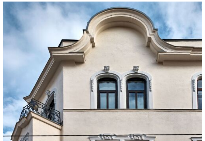
Bergsteiggasse 26A | Fassade
