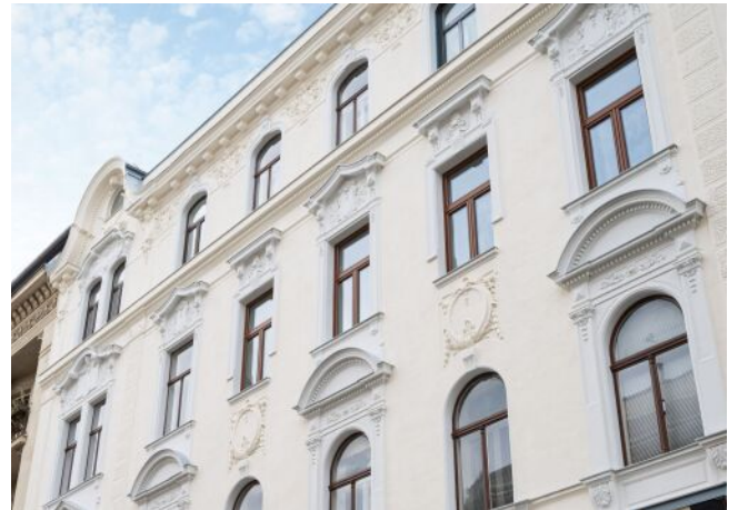
Bergsteiggasse 26A | Fassade
