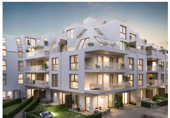
Schumanngasse | Fassade Abend
