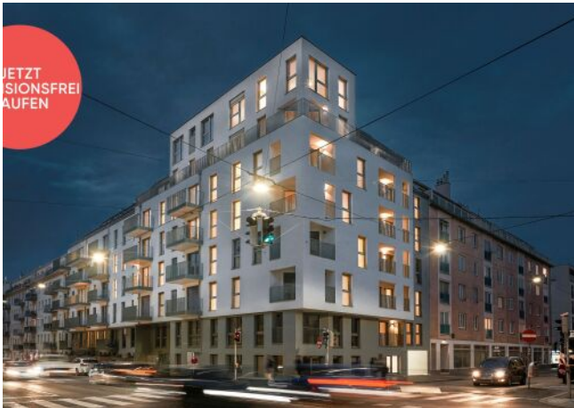
Arndtstraße 50 | Fassade Nacht
