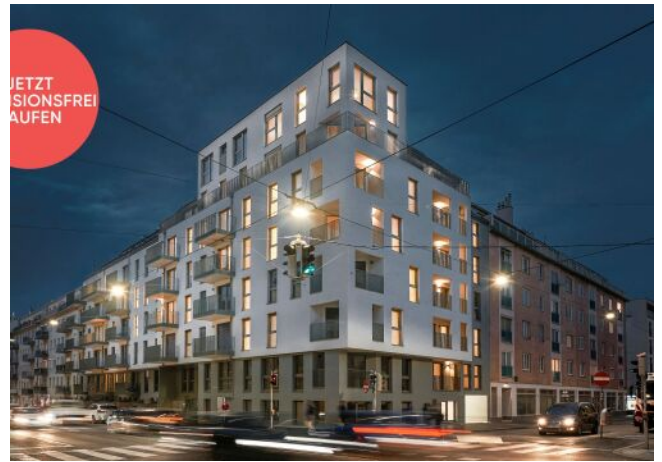
Arndtstraße 50 | Fassade Nacht
