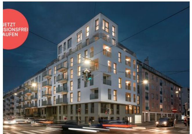
Arndtstraße 50 | Fassade Nacht
