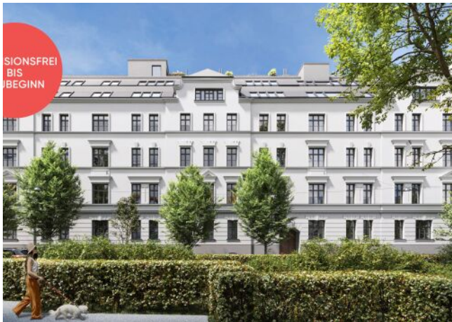
Rosegggasse | Fassade Frontal
