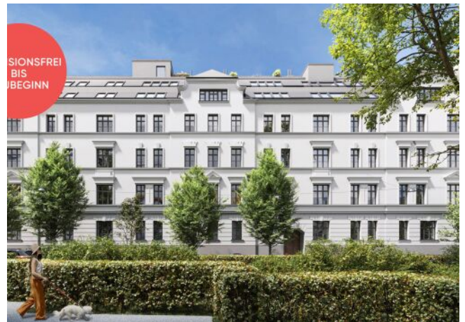
Rosegggasse | Fassade Frontal
