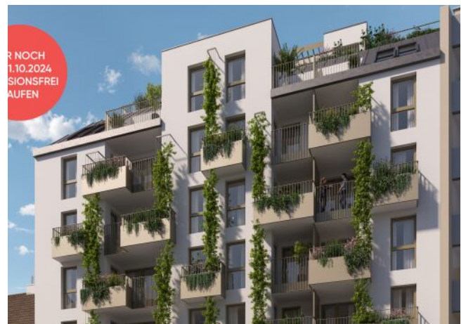
Ottakringer Straße 26 | Fassade
